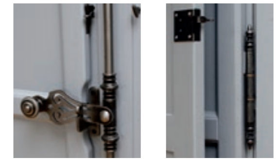
Usinage spécifique du montant du volet si fermeture par espagnolette Paumelle turlupet à plaque vissée pour la fenêtre et le volet intérieur
