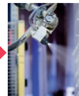
Application du traitement et de la protection
